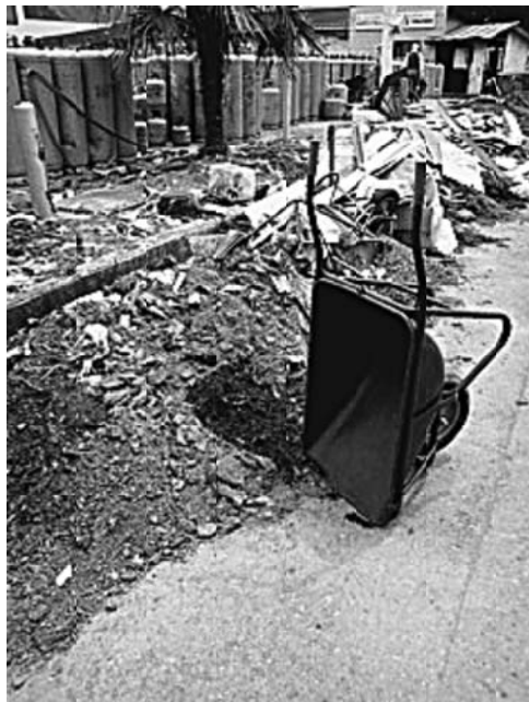
【瓦礫とヘドロの撤去作業】
