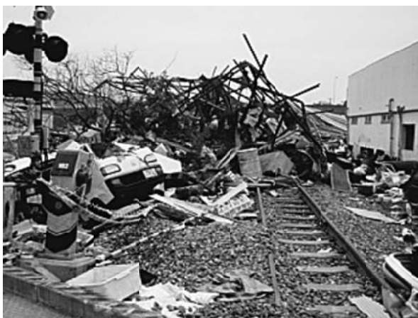
【大船渡にて現場近くの踏切と川】
