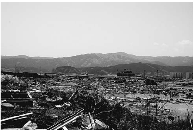
【海岸から1キロ離れたところにも津波の被害】
