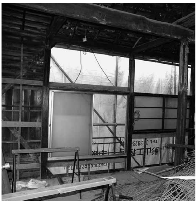
【木造耐震リフォーム工事中】
