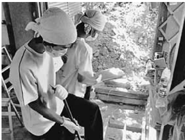
【解体現場で実習する中学生】
