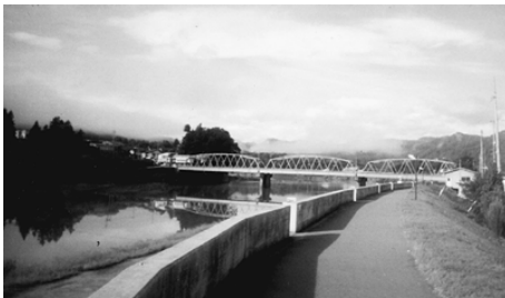
下流で千曲川に合流する犀川にかかる橋
