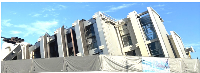
倒壊したビルもまだそのままに
