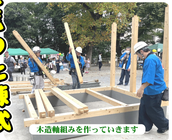
木造軸組み組み立ての様子
